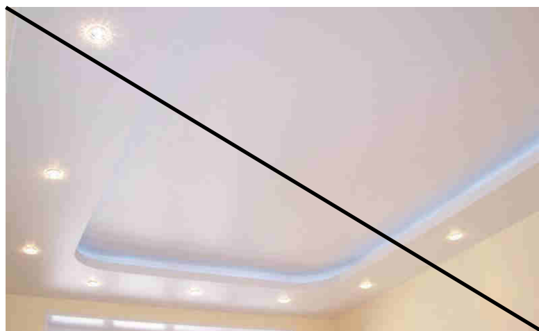
Плохо Многоуровневые гипсокартонные конструкции
